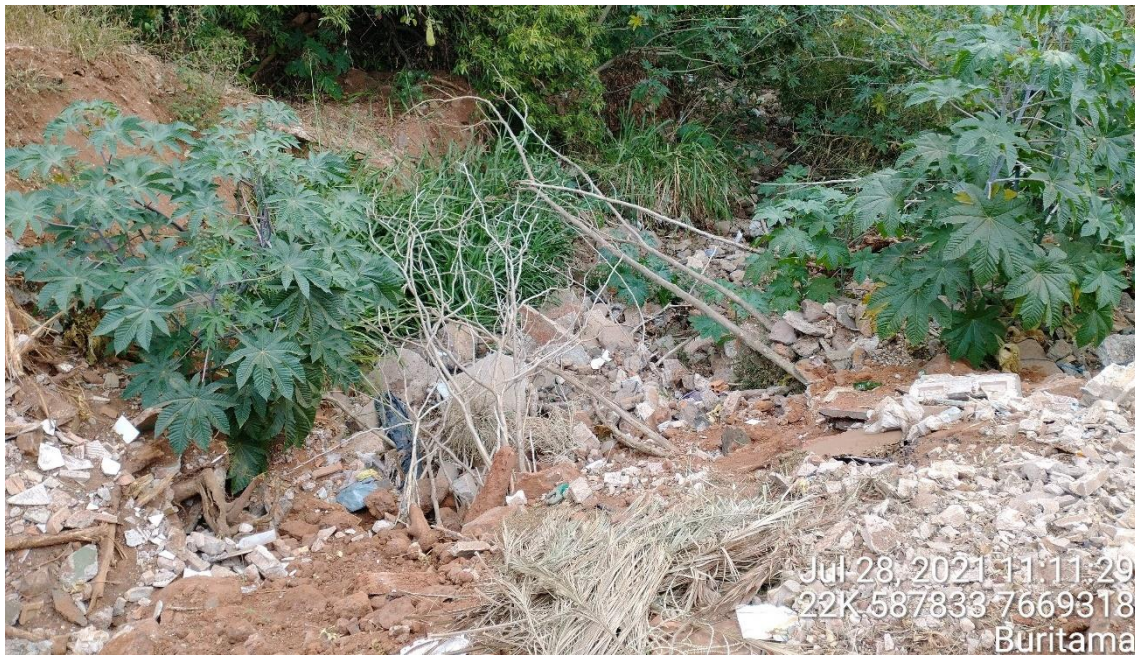
Figura 12 - Entulho em saída de dispositivo de drenagem
